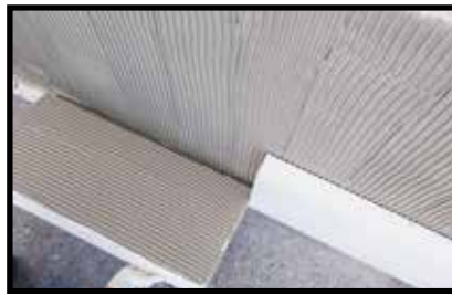
Posa dei pannelli isolanti con doppia spalmatura
