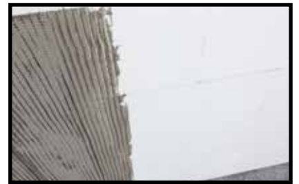
Applicazione primo strato PLANITOP HDM MAXI
