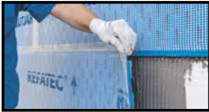
Stesura materassini Ceravent dall'alto verso il basso, sfalsati
