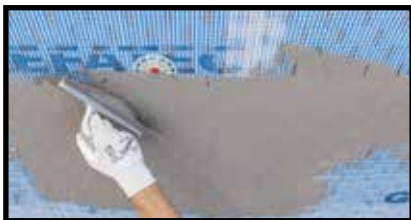
Rasatura e riempimento della retina spatola dentata in senso verticale
