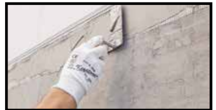
Posizionamento del profilo con annegamento della retina
