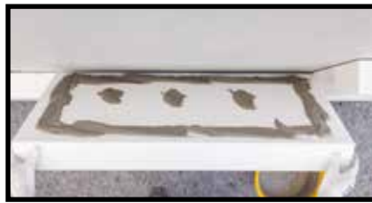
Incollaggio dei pannelli isolanti con spatola dentata in senso verticale
