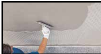
Rasatura di adesione
