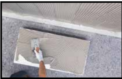
Posa dei pannelli isolanti con doppia spalmatura (retro pannello)
