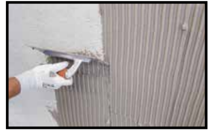
Posa dei pannelli isolanti con doppia spalmatura (muratura)
