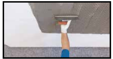
Stesura del collante con spatola dentata in senso verticale
