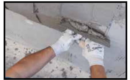
Secondo strato PLANITOP HDM MAXI
