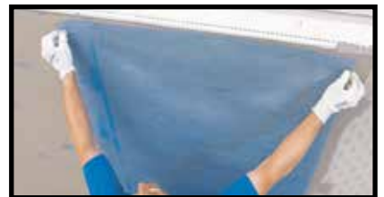
Stendere rete armatura CeraVent
