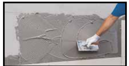
Doppia spalmatura (muratura)
