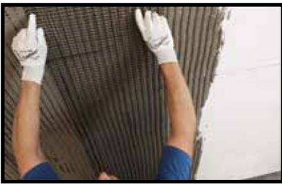
Applicazione rete MAPEGRID G120
