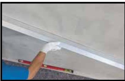
Controllo planarità dell'intonaco strutturale
