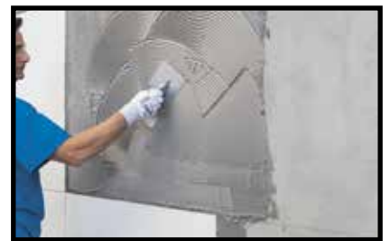
Doppia spalmatura (muratura)
