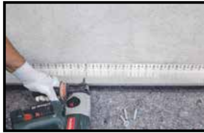
Posizionamento dei profili di partenza MAPETHERM BA
